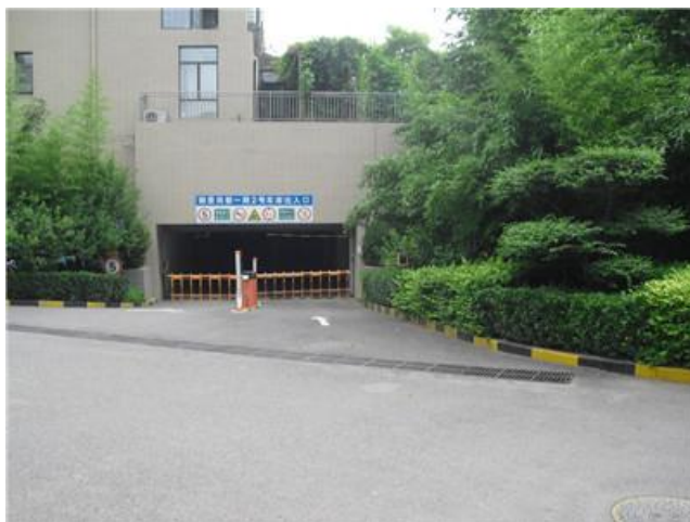
地下停车场入口
