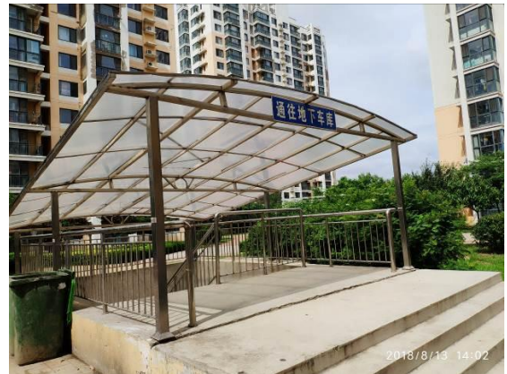
地下车库入口
