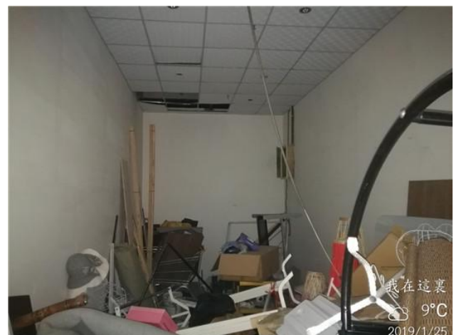
估价对象内部
