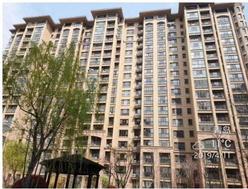
估价对象所在楼栋南立面
