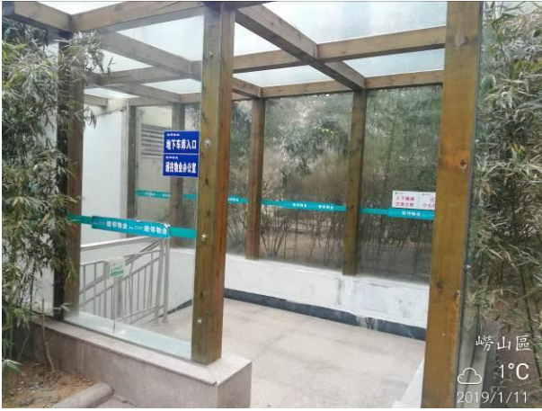
地下车库入口
